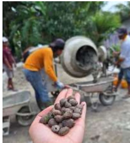
Gambar 2. Limbah Biji Kelapa Sawit yang di Campurkan pada Pengecoran Perbaikan Jalan
