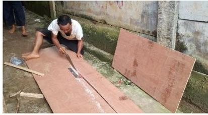
Gambar 8. Poses Pemotongan Tripleks dan Kaso untuk Bekisting Abutmen
