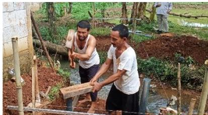
Gambar 5. Pemancangan Pipa Galvanis Sebagai Pondasi Abutmen
