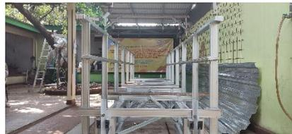
Gambar 14. Rangka Jembatan Baja Ringan Selesai Dibuat
