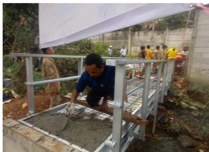
Gambar 19. Pengecoran Plat Lantai Jembatan
