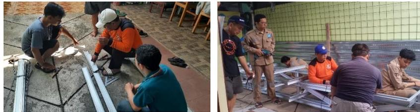
Gambar 13. Pembuatan Rangka Jembatan Baja Ringan
