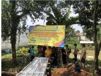
Gambar 16. Pemasangan Rangka Jembatan Baja Ringan di atas Kepala Jembatan
