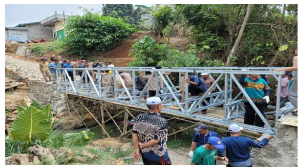
Gambar 10. Proses pengangkutan dan pemasangan jembatan baja ringan
