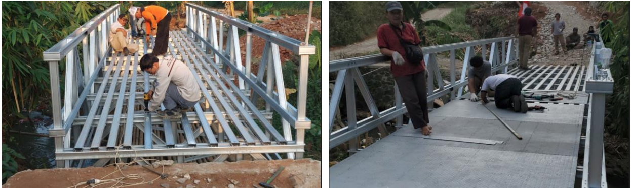
Gambar 11. Proses pemasangan lantai jembatan
