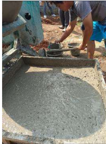
Gambar 7. Beton SCC dengan Blended Portland Cement
