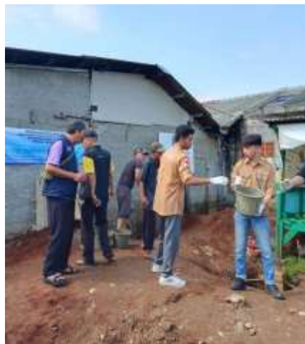
Gambar 8. Proses pengangkutan adukan beton dari lokasi pengadukan ke titik- titik pondasi
