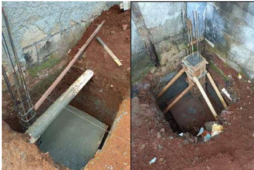
Gambar 9. Pondasi Telapak yang telah dicor dengan Beton SCC
