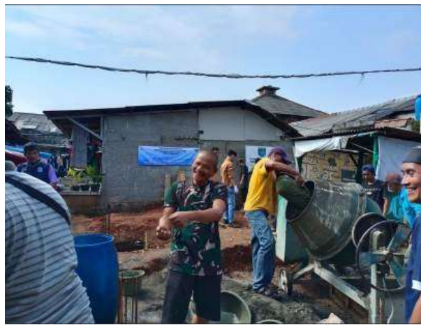
Gambar 6. Proses Pengecoran Pondasi Telapak dilakukan secara bergotong royong antara Warga, Mahasiswa dan dosen Pendamping
