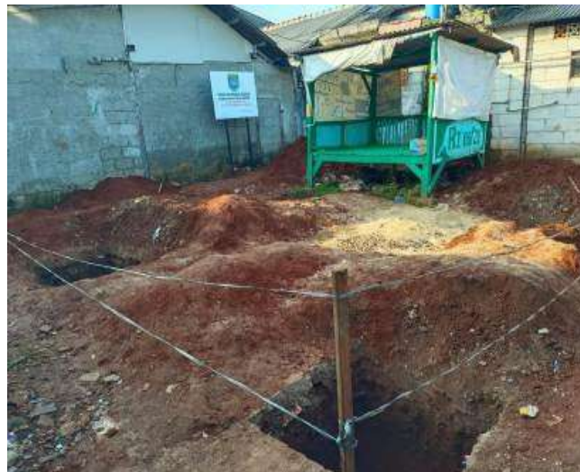
Gambar 5. Penentuan titik-titik pondasi telapak dan penggalian tanah
