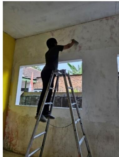
Gambar 5. Pekerjaan pembersihan dan plamir dinding
