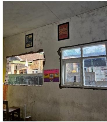
Gambar 7. Proses pelepasan kusen jendela
