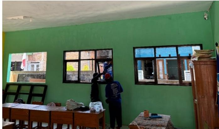
Gambar 9. Pekerjaan pemasangan kusen aluminium
