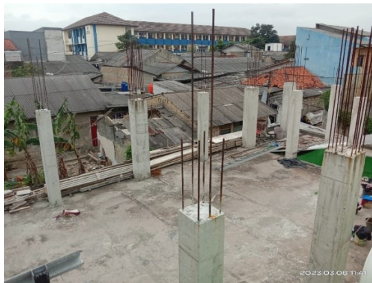
Gambar 1. Kondisi Salah Satu Bangunan Lantai 2 Pondok Pesantren Ashhaburratib yang sudah Terpasang Kolom dan Tulangan
